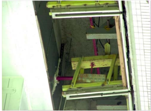
圖 3 玻璃懸吊支架 2
