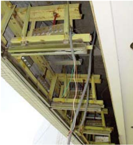
圖 2 玻璃懸吊支架 1
