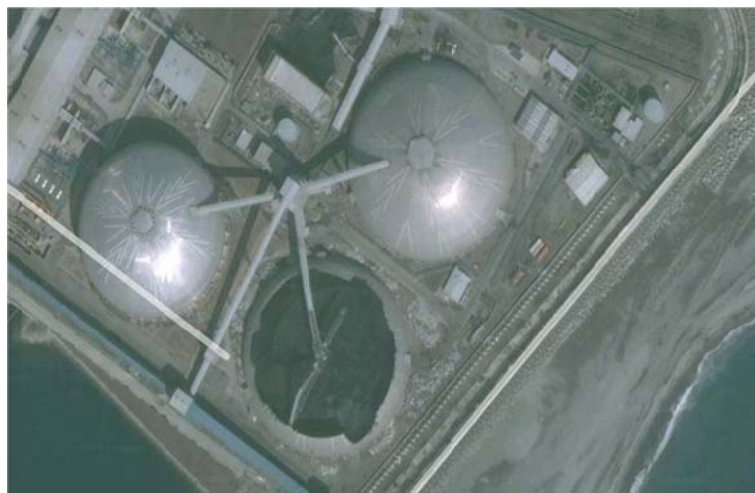
圖 5 花蓮和平電廠煤倉 Dome B 受納坦颱風破壞後之空照圖
