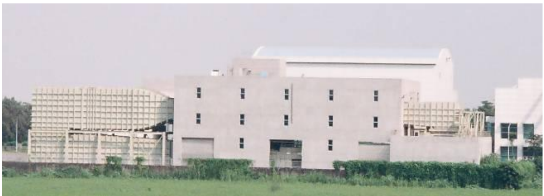
圖三 內政部建築研究所風洞實驗館全貌
